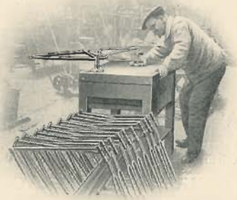
Dressage d'un cadre sur le marbre
