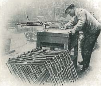
Dressage d'un cadre sur le marbre
